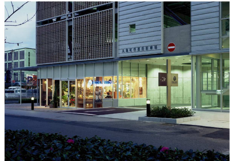
レンガルーバーを近くで見ると、手づくりのイメージが伝わる
