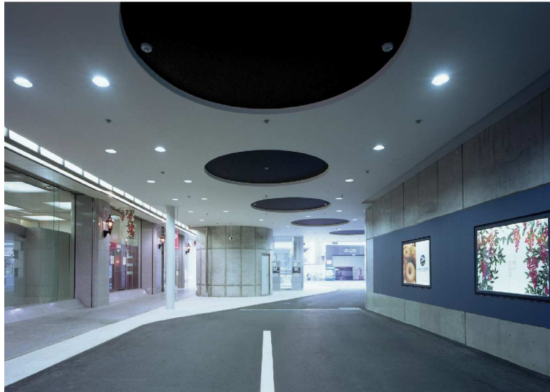
通路；三越に隣接することから、地元出身の画家猪熊弦一郎がデザインした三越の包装紙をイメージさせる天井をつくった。ただしここでもコンクリート打ち放しの壁と石膏ボードという安い素材のくみあわせを用いている。
