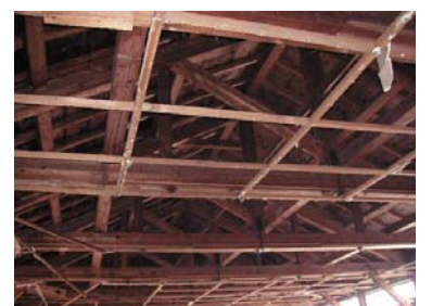
工事に着手し天井をはがした状態
