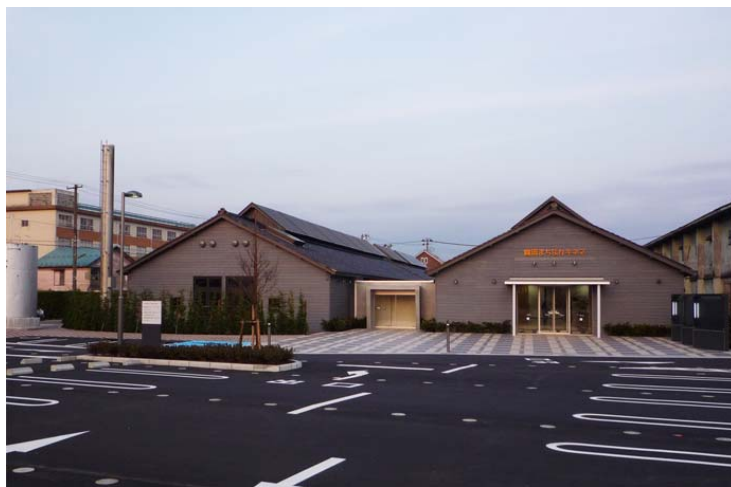
北側(左手)には旧工場の歴史を継承するタンクと煙突がみえる
