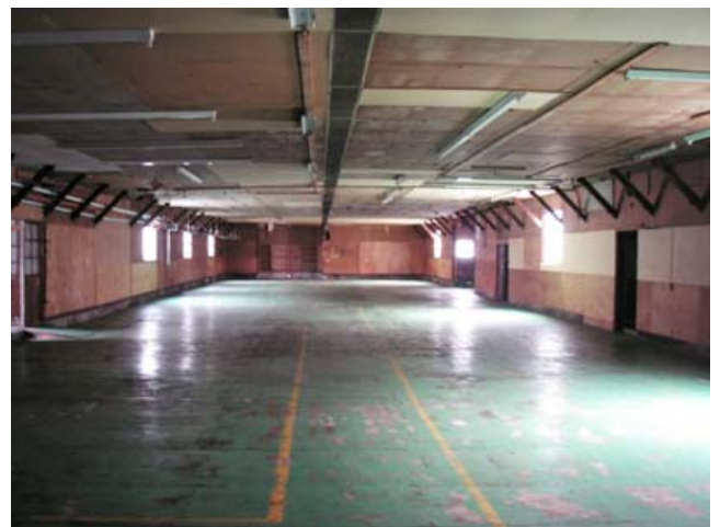
操業していたときは天井が張られていた
